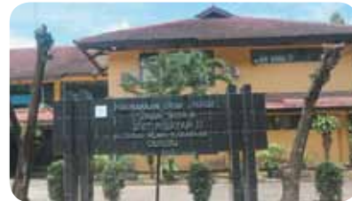
Kantor Unit Wilayah II - Regional Unit Office II
