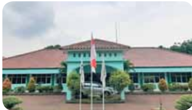
Kantor Unit Wilayah I - Regional Unit Office I
