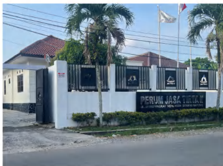
Kantor Unit Wilayah VI Regional Unit Offices VI
